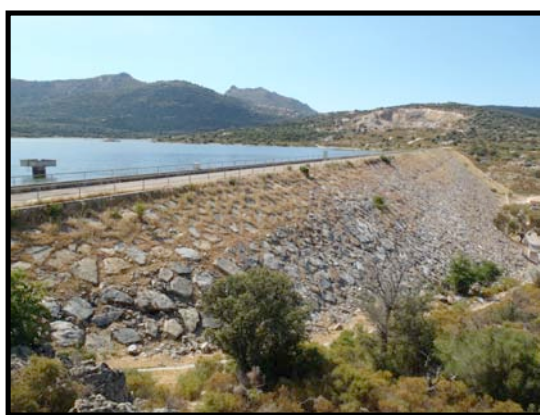
Figure 39 : Barrage de Codole sur le Regino (MRM)
