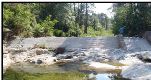
Figures 105 et 106 et 107: Seuils du pont de la D468 (105), de l'ancienne prise OEHC (106) et de la prise OEHC (107) sur l'Oso (MRM)
