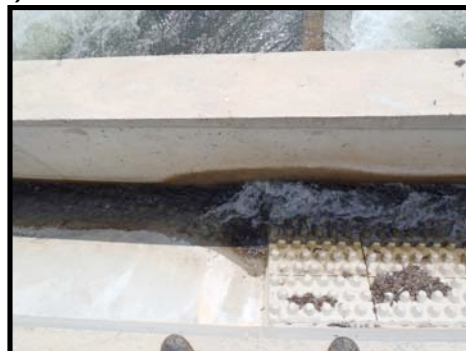
Figures 128 et 129: Seuil de la microcentrale du pont de Calzola sur le Taravo (128) et déconnexion de la passe à anguilles avec le bief amont (129) (MRM)
