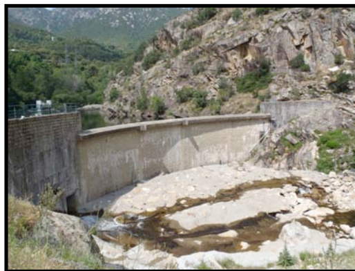
Figure 37 : Barrage d'Ocana sur le Prunelli
