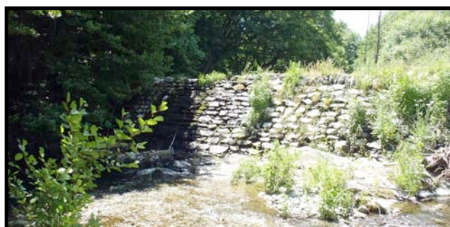
Figure 80 : Seuil de la prise OEHC sur l'Aliso (MRM)
