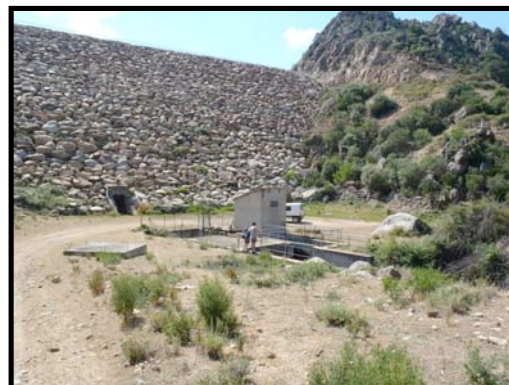
Figure 33 : Barrage de l'Ortolo sur l'Ortolo (MRM)
