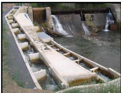
Figure 14 : Passe à bassins successifs (barrage de la Forge sur l'Aude) (MRM)
