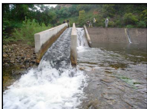
Figure 17 : Passe à ralentisseurs (seuil de la Voulte sur le Jaur) (MRM)
