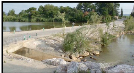
Figure 60 : Passage à gué de Rivesaltes (MRM)
