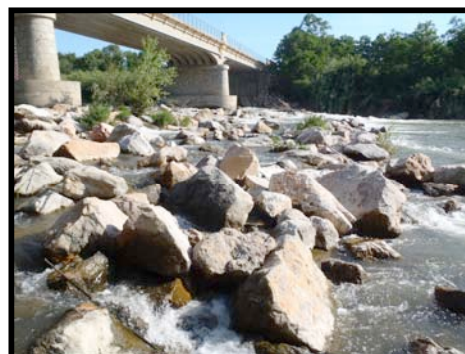
Figure 52 : Seuil du Pont de Canet sur la Têt (MRM)
