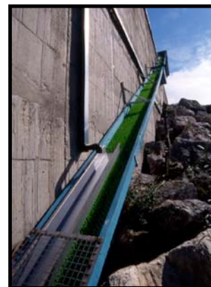
Figure 18 : Rampes de reptation sur l'usine-écluse de Beaucaire sur le Rhône (MRM)
