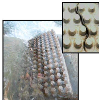
Figure 19 : Dalles à plots bétons sur le Vidourle (MRM)
