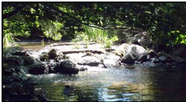
Figure 118 : Seuil aval du pont de la Balanina sur le Regino (MRM)
